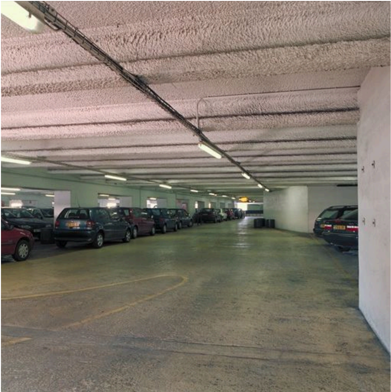
Vue d'ensemble d'un niveau de parking
