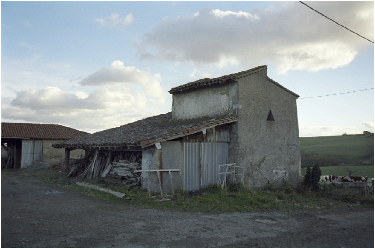
Colombier à Saint-Sixte, la Treille (1987 B1 484), type I. Façade postérieure.
