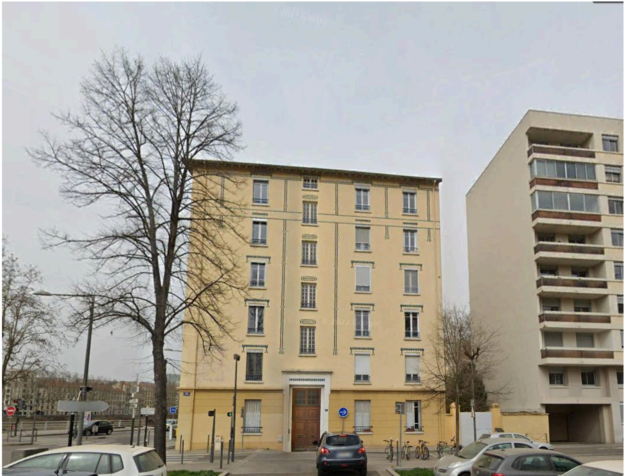
Vue façade sud rue des Entrepôts
