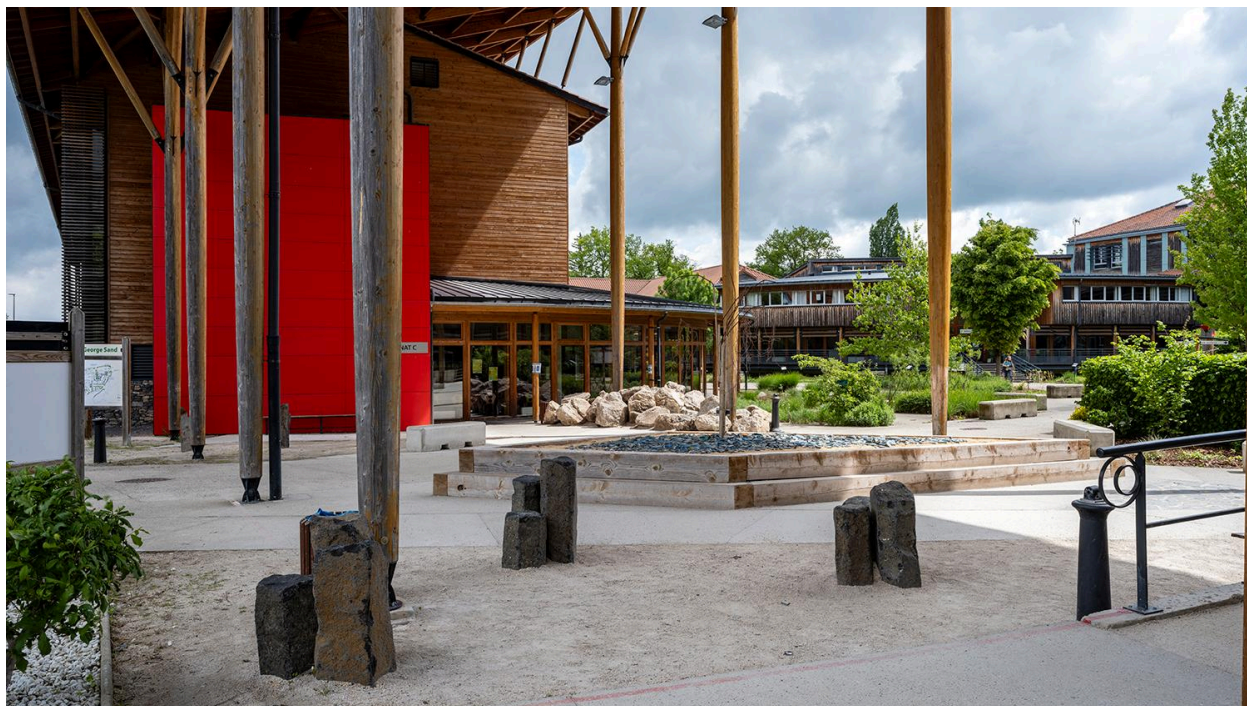
Vue rapprochée de l'aménagement au niveau de l'entrée du lycée, depuis le sud
