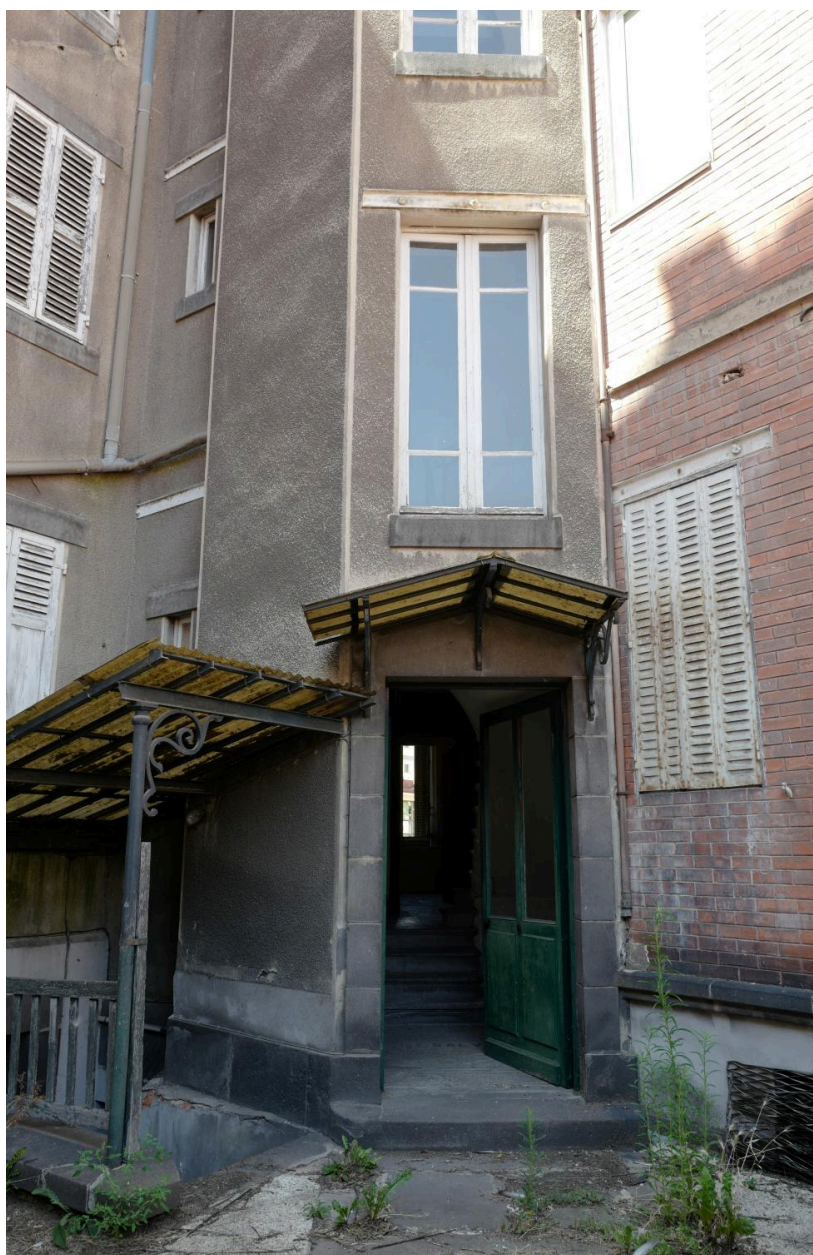
Porte d'entrée de la tour d'escalier sur cour
