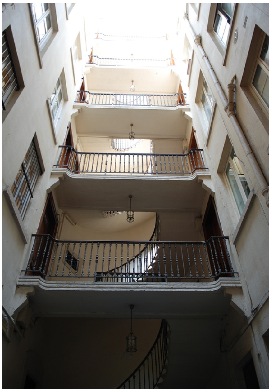
Escalier ouest : vue en contre-plongée
