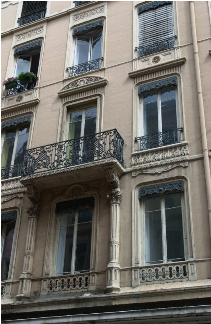
Rue Ferrandière : vue partielle de l'élévation
