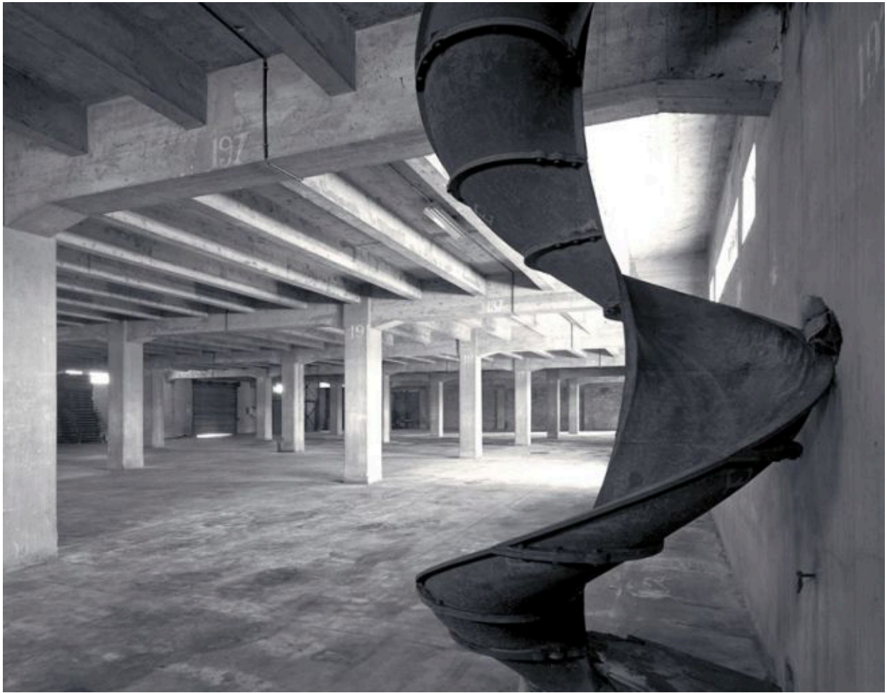
Intérieur du bâtiment de 1927 (bâtiment sud) : à l'étage, vue d'ensemble depuis le sud-est et le tourniquet de l'angle sud-est
