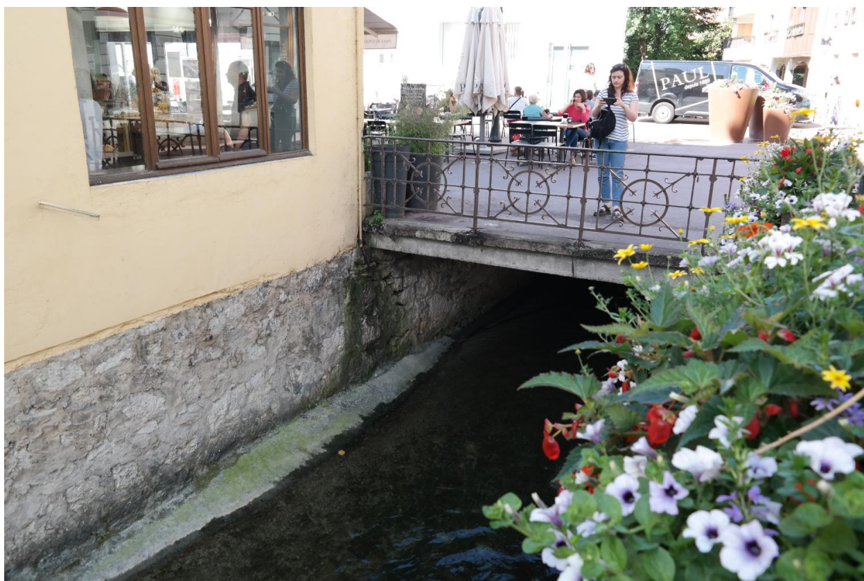
Pont des Cordeliers, vue de la face amont
