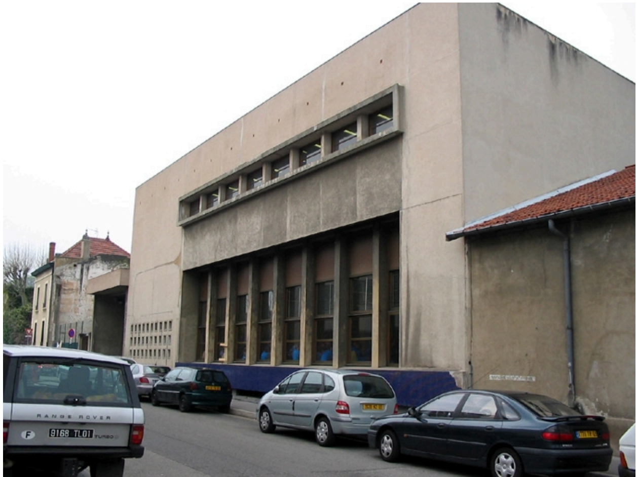
Vue est du restaurant d'entreprise rue Berjon
