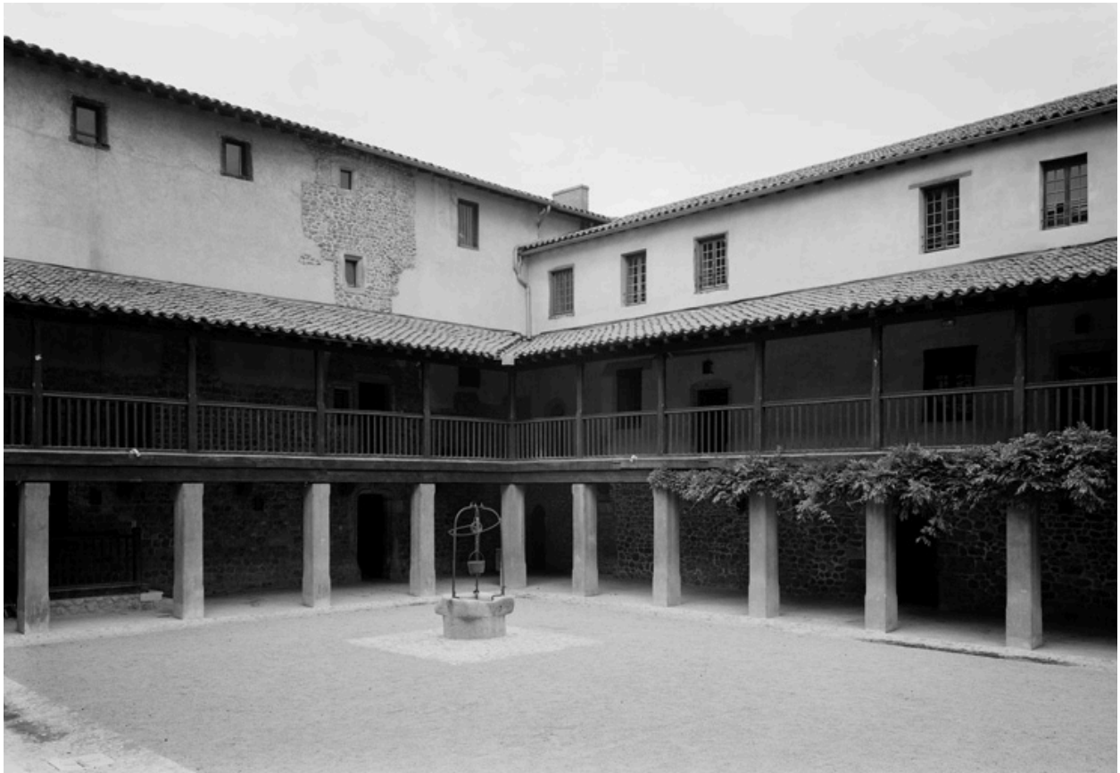
Vue de l'angle nord-ouest du cloître.
