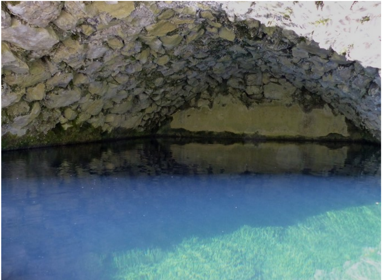
Réservoir sous voûte, ferme au quartier des Routes.
