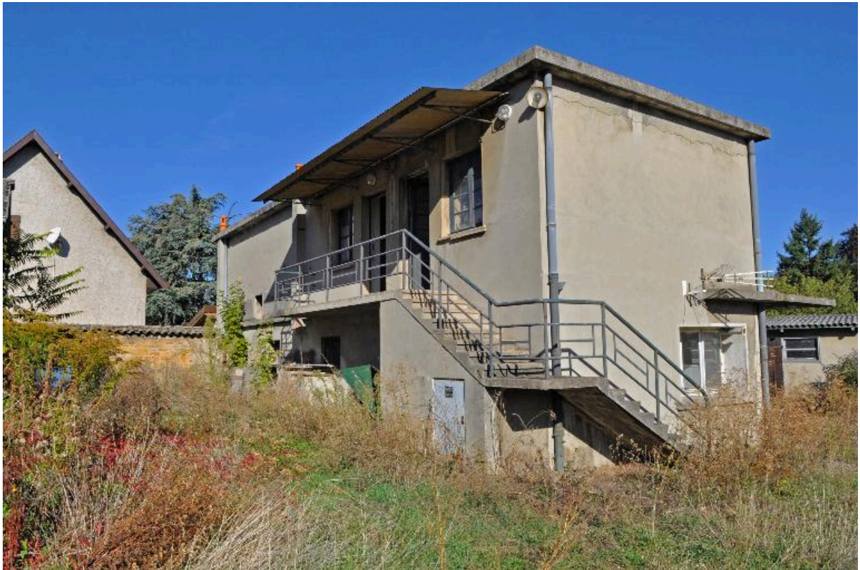
Vue du bâtiment technique au sud du parc, élévation sud
