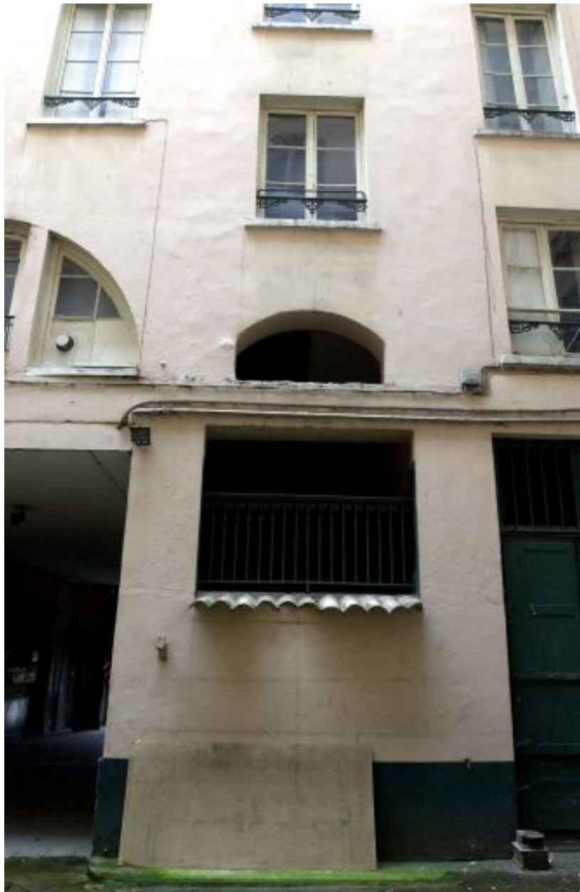
Vue de la travée d'escalier de l'immeuble sur rue
