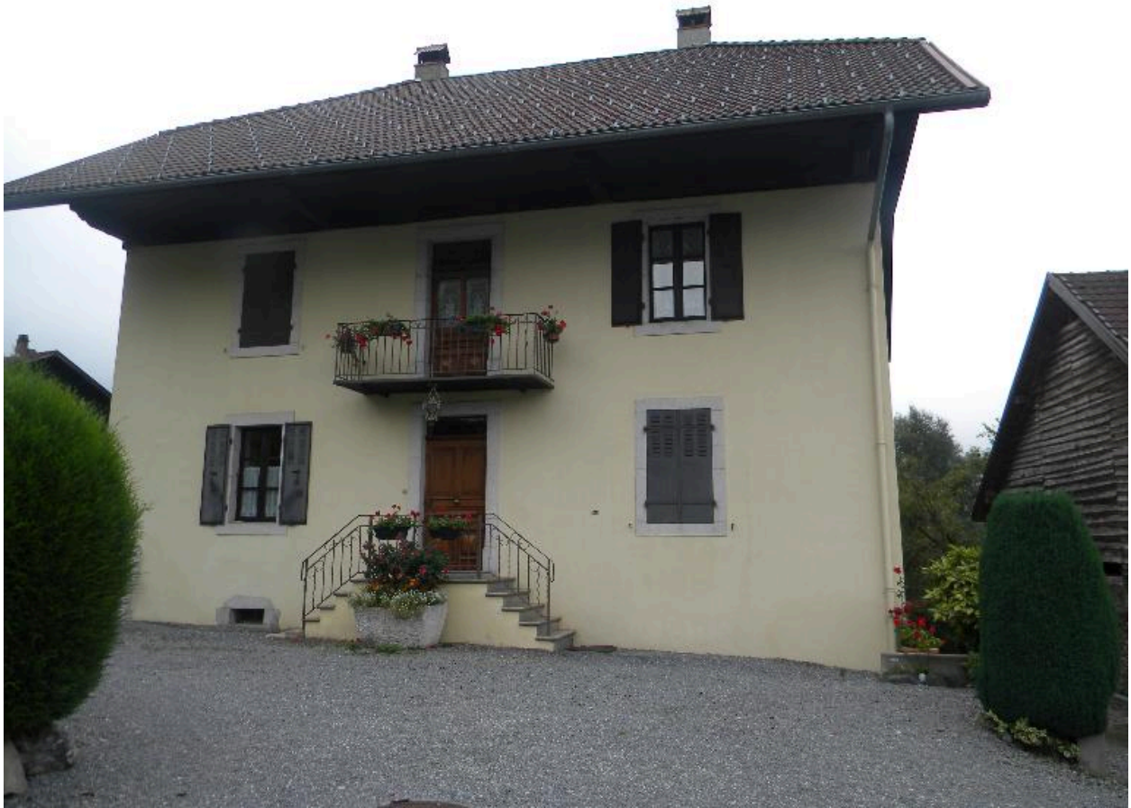
Vue de la façade principale d'une ancienne maison modifiée (2008 E10 1459)
