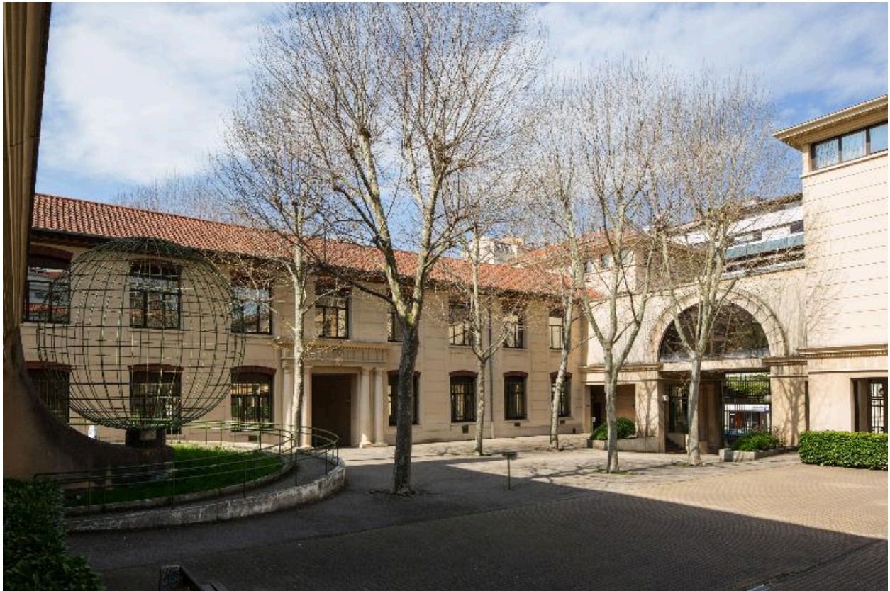
Vue du bâtiment A avec loge du gardien et entrée sur l'avenue de la Libération
