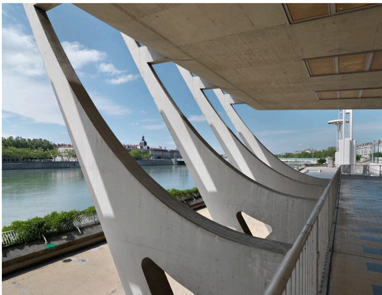
Vue de la terrasse (niveau du quai, état en juin 2012).
