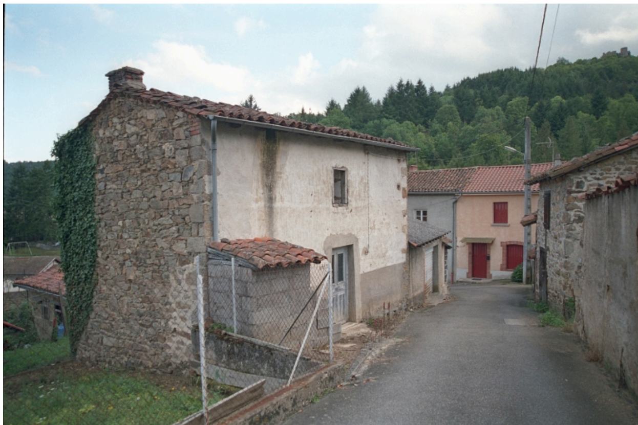
Sail-sous-Couzan, La Font Fort (1986 B1 396). Logge de type E2b2. Vue d'ensemble d'une logge convertie en habitation.
