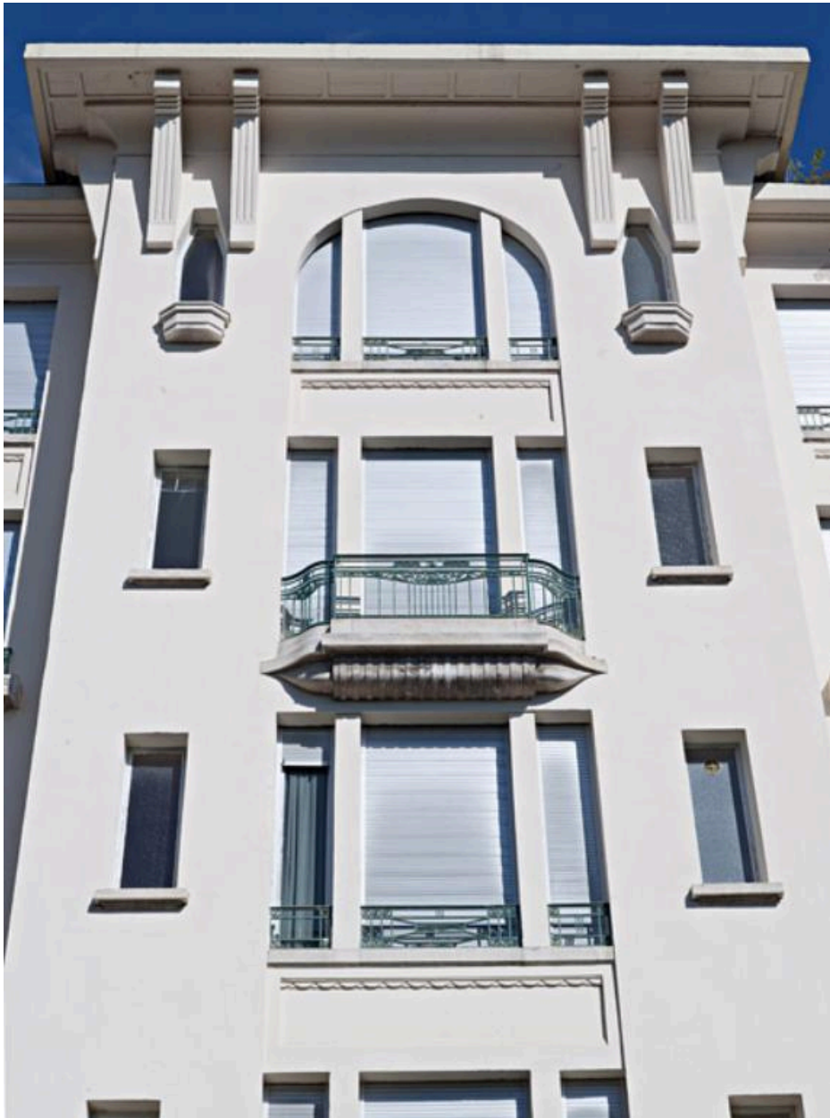
Hôtel-Dieu de Clermont-Ferrand. La polyclinique, façade principale, niveaux supérieurs de l'avant-corps du pavillon nord.
