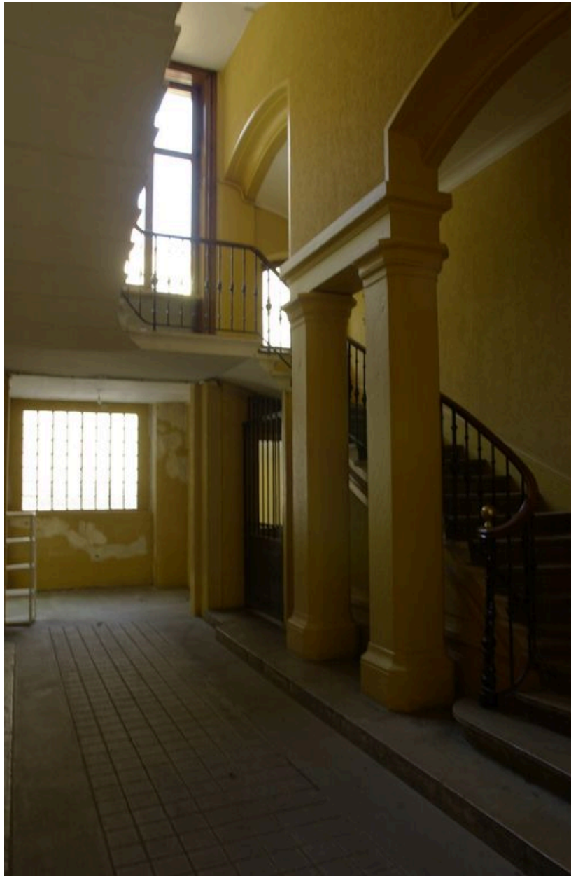
Vue du vestibule et de la 1re volée décalée de l'escalier
