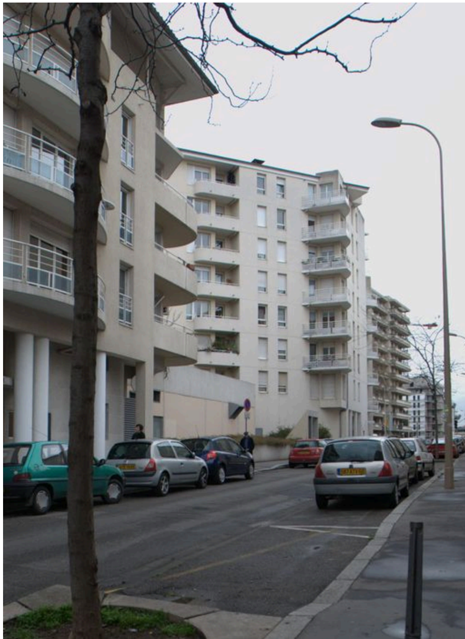
Elévation postérieure, vue partielle
