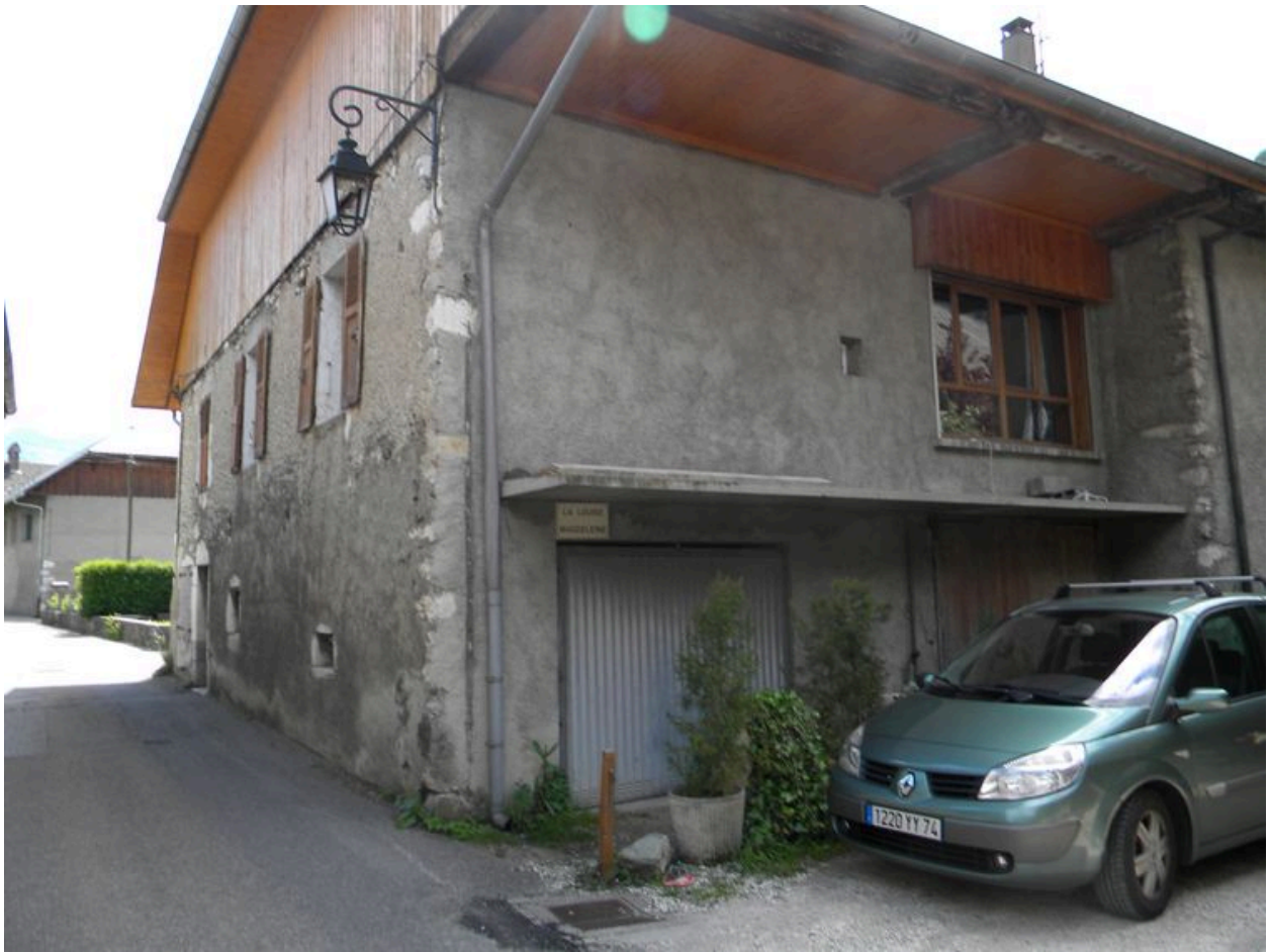
Vue de la façade arrière.
