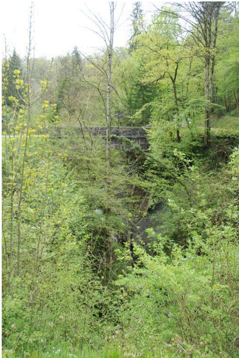
Vue du pont sur la RD 211 et des rives du Sierroz, vers Chez Prima.
