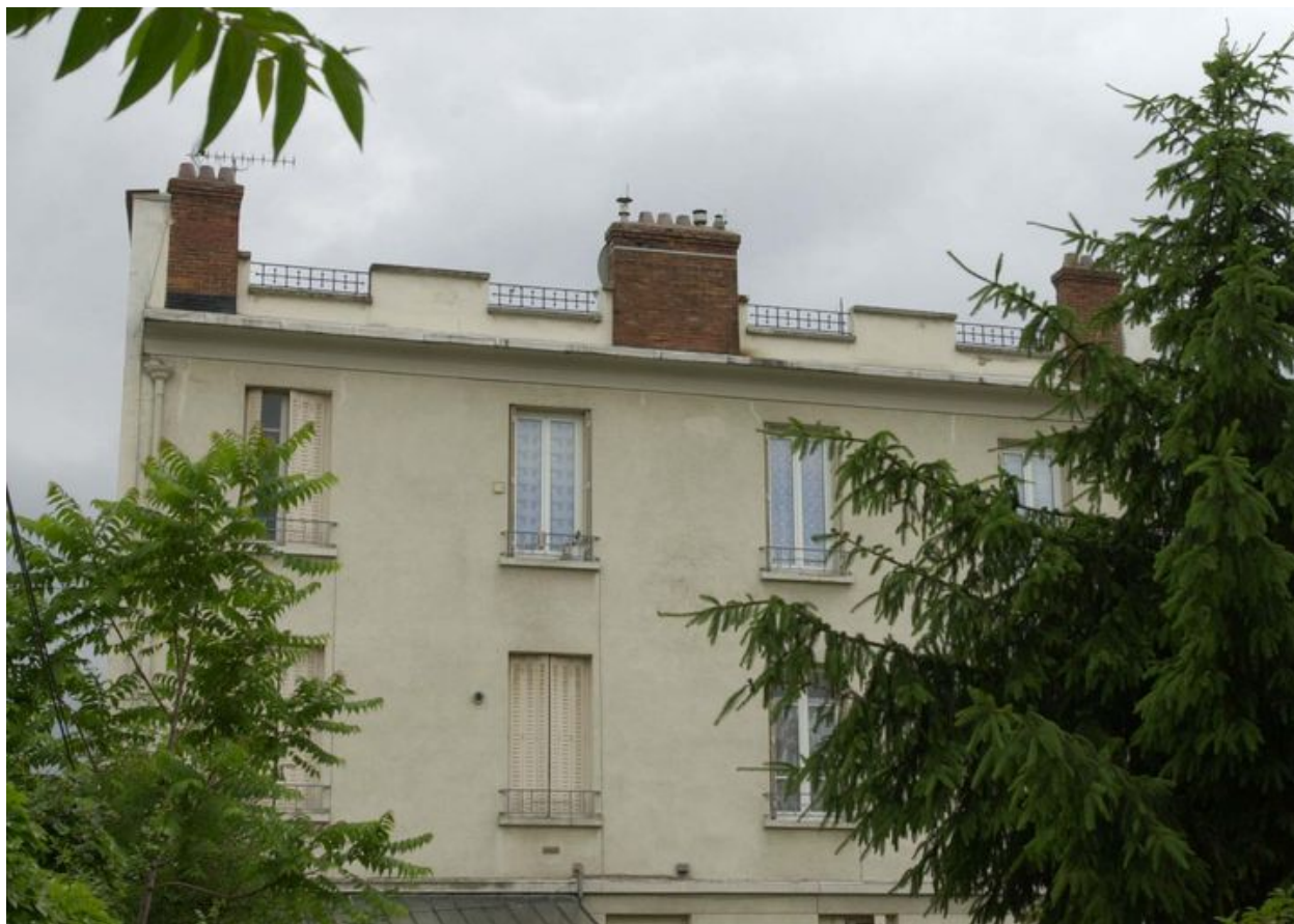
Façade principale, détail du garde-corps du toit en terrasse
