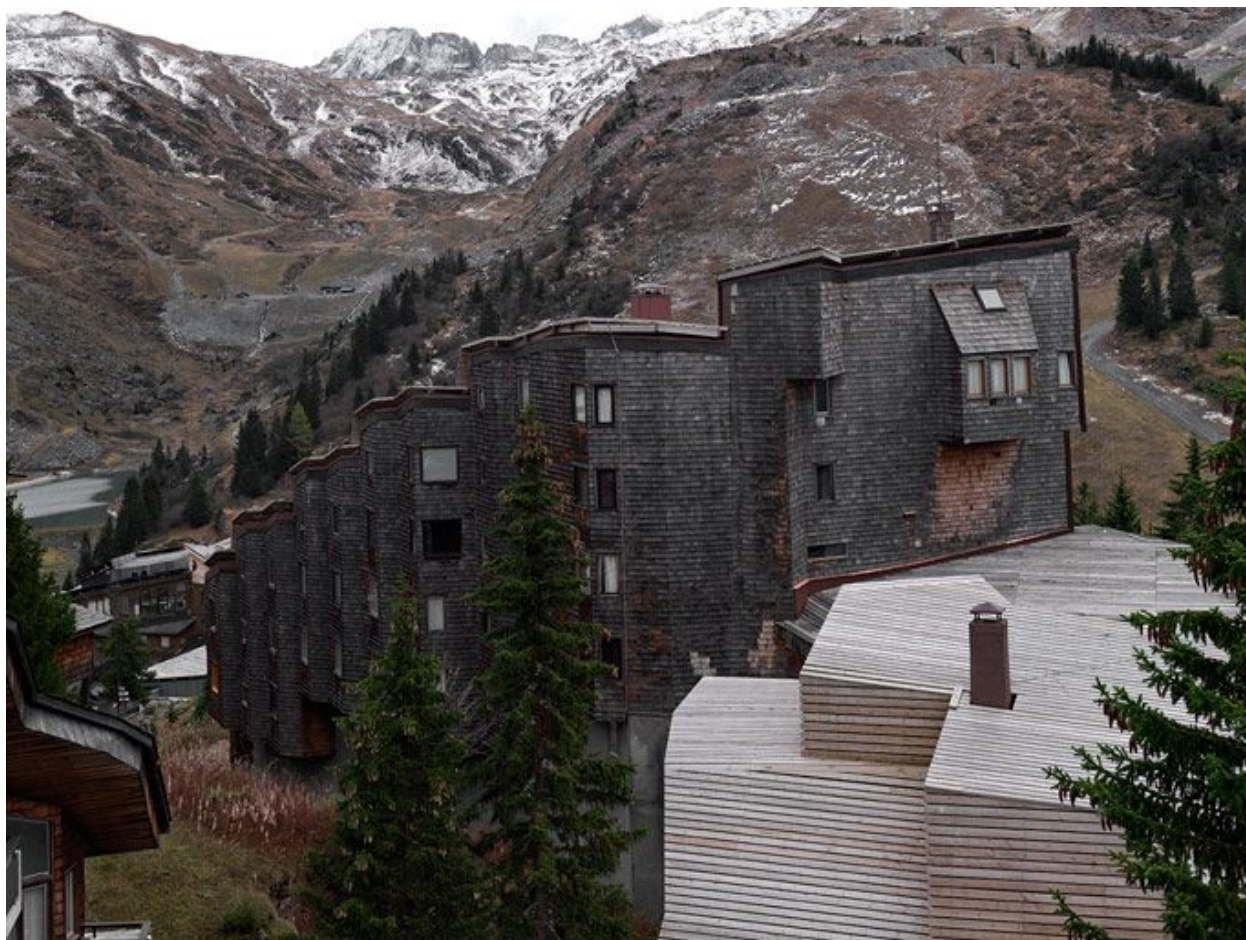
Façade nord vue depuis le nord-ouest
