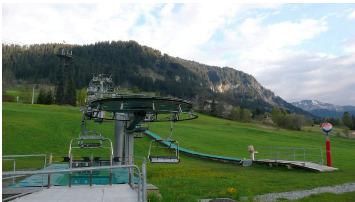
Remonte-pente de Rochebrune. La station inférieure
