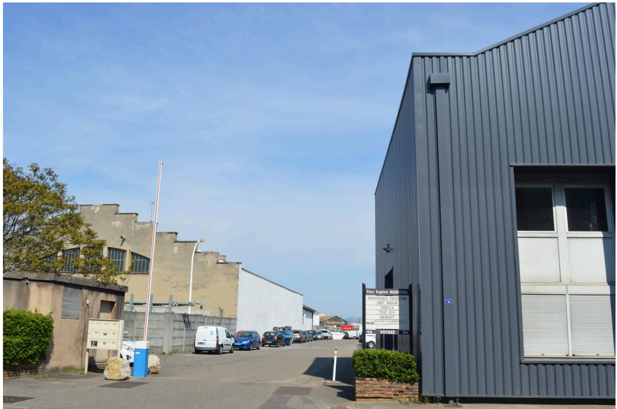
Véninov - vue de l'usine depuis la rue Eugène Maréchal - Parc Eugène Maréchal pépinière d'entreprises
