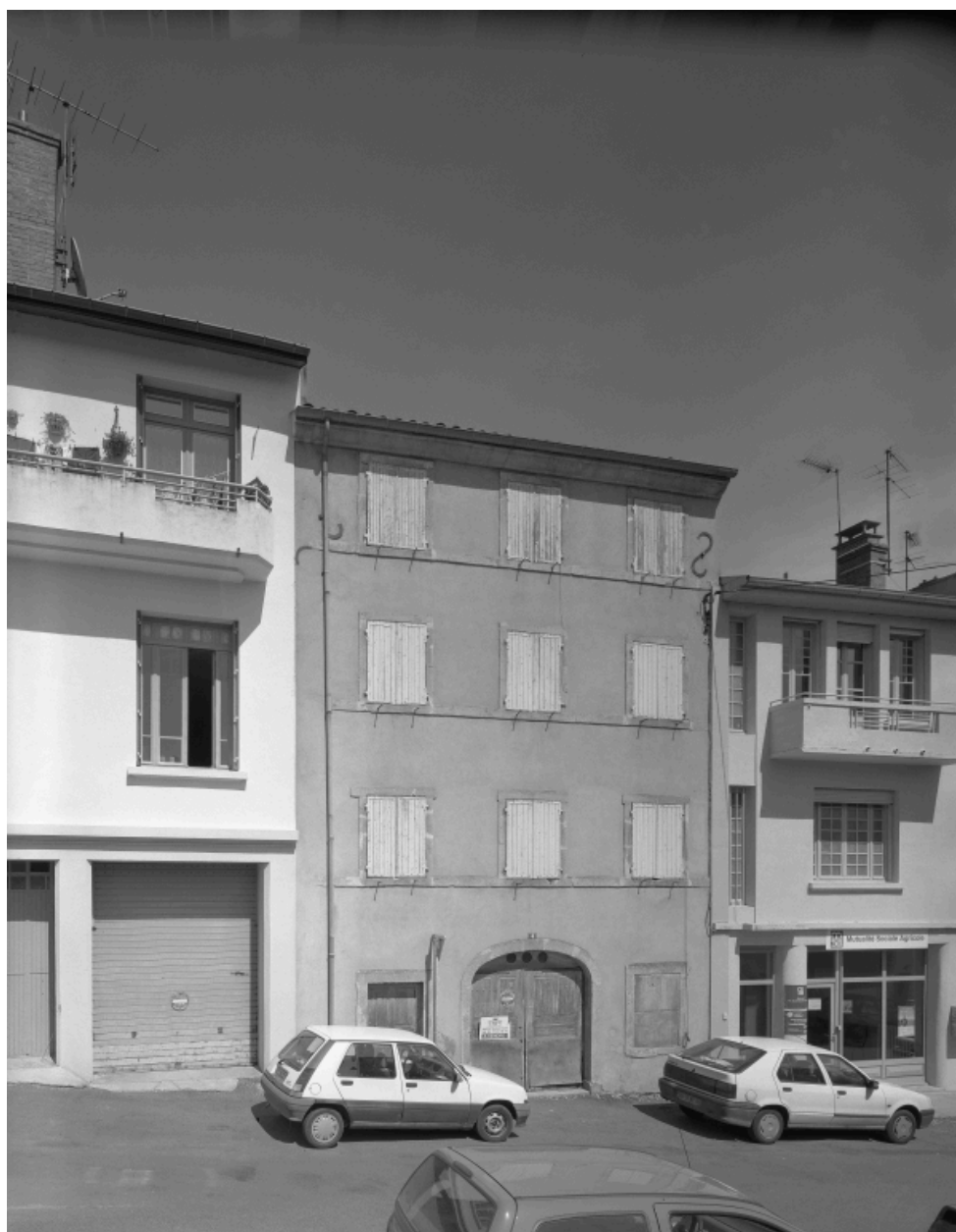
Maison, 4 rue Gustave Labrosse. Vue générale de la façade principale, de l'ouest.
