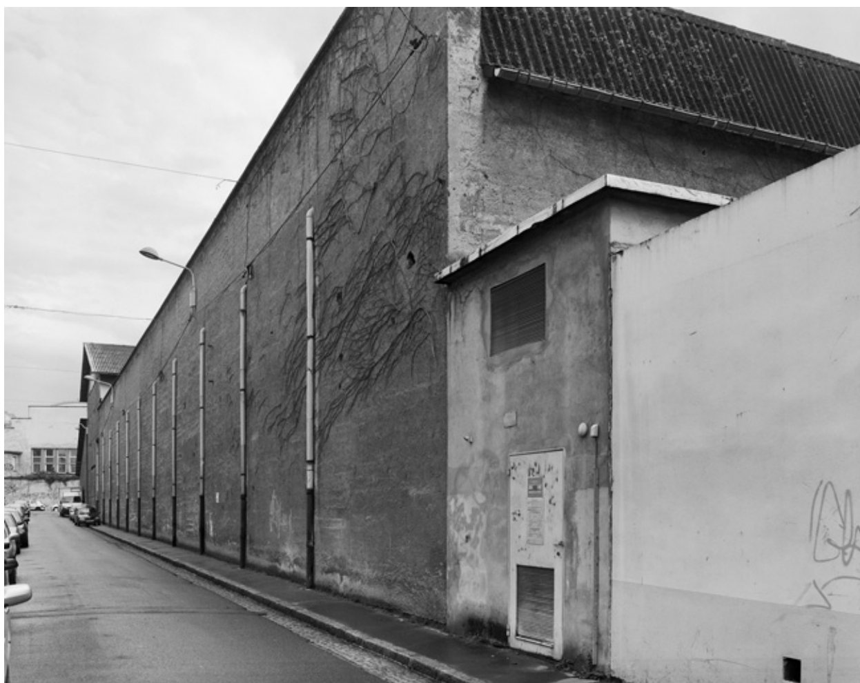
Façade est rue du docteur Horand : évacuation des eaux pluviales
