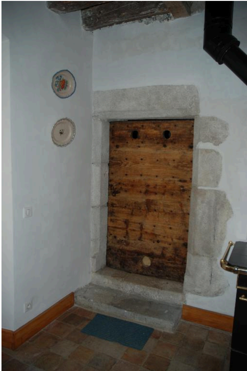
Rez-de-chaussée. Intérieur de la cuisine, porte d'entrée de la cave 1.
