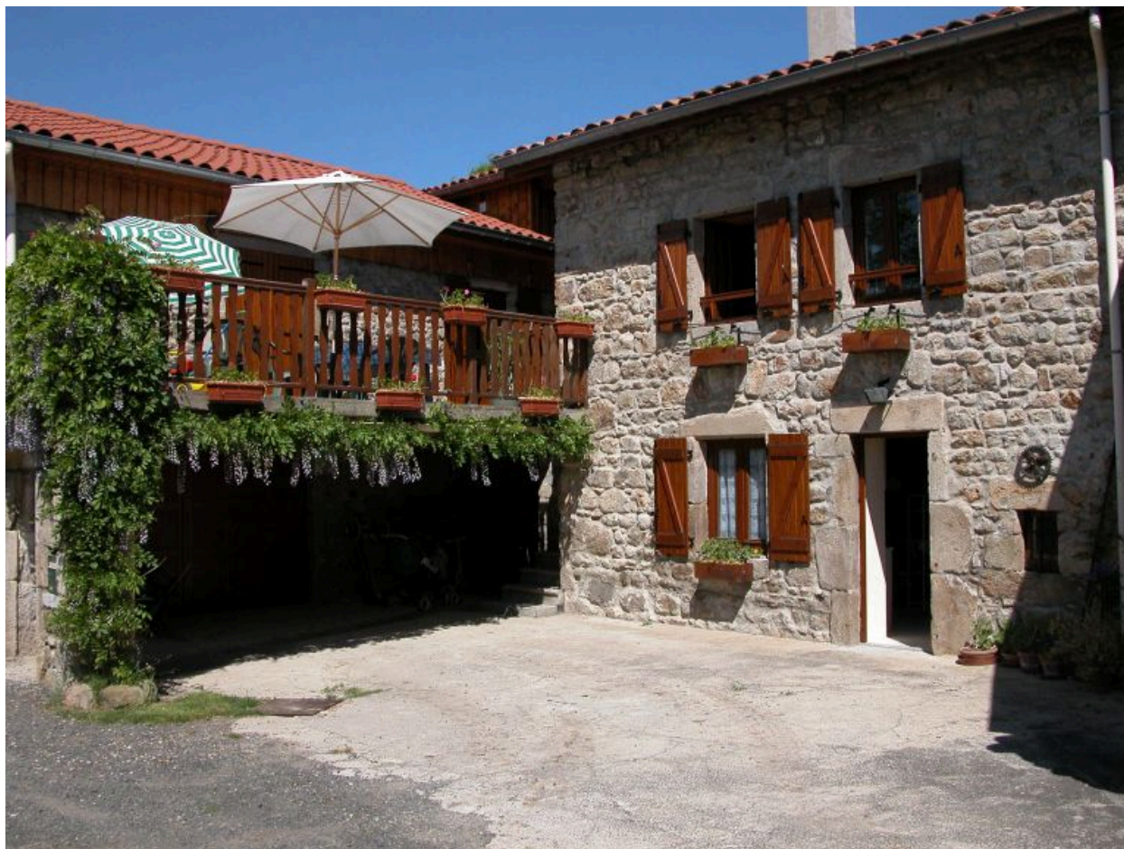
Vue d'ensemble de la façade du logis.
