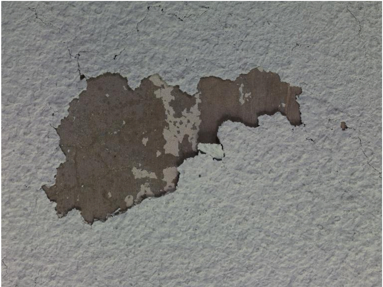
Mur nord : détail du décor d'origine dans une lacune d'enduit
