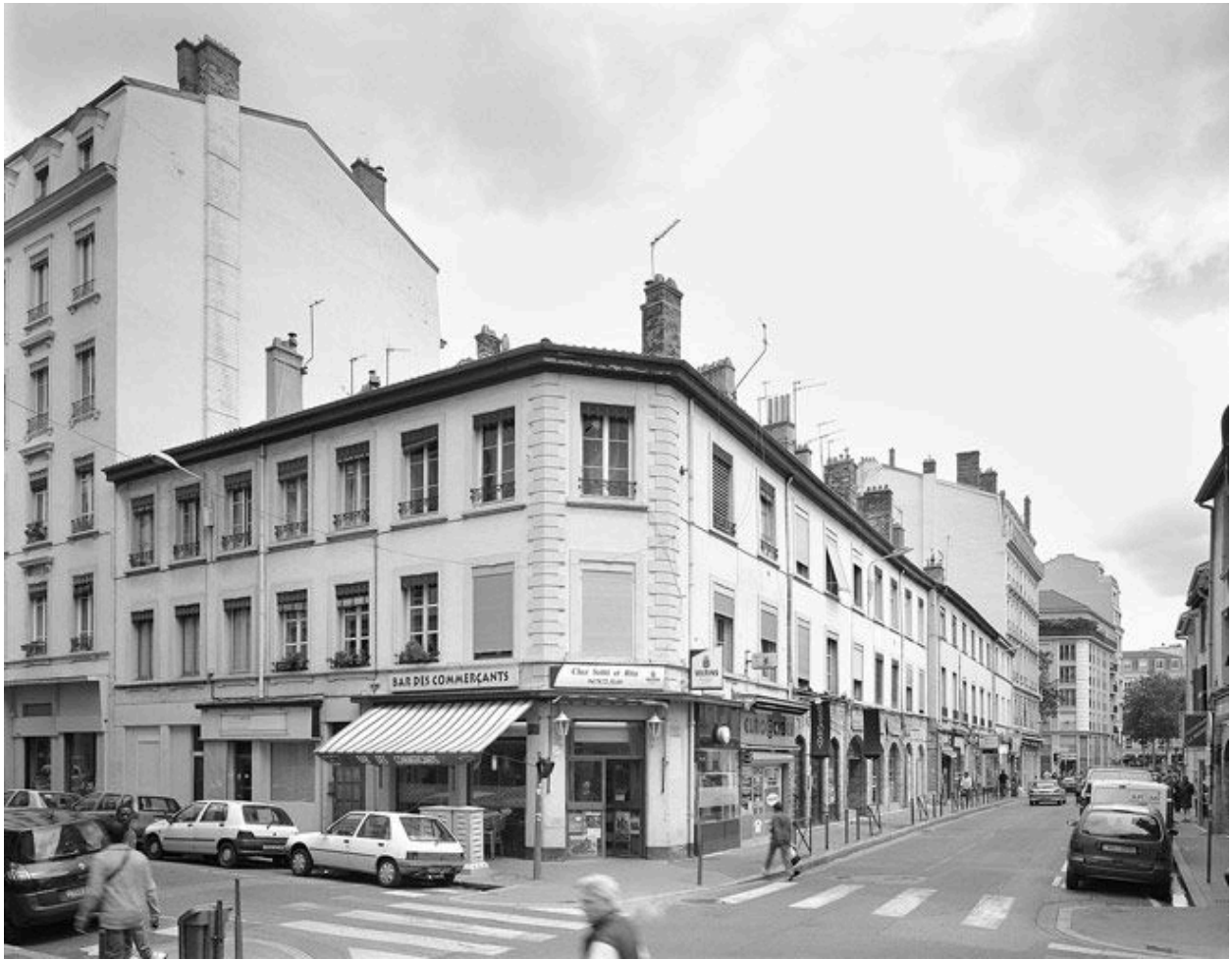
Vue générale depuis le sud-ouest
