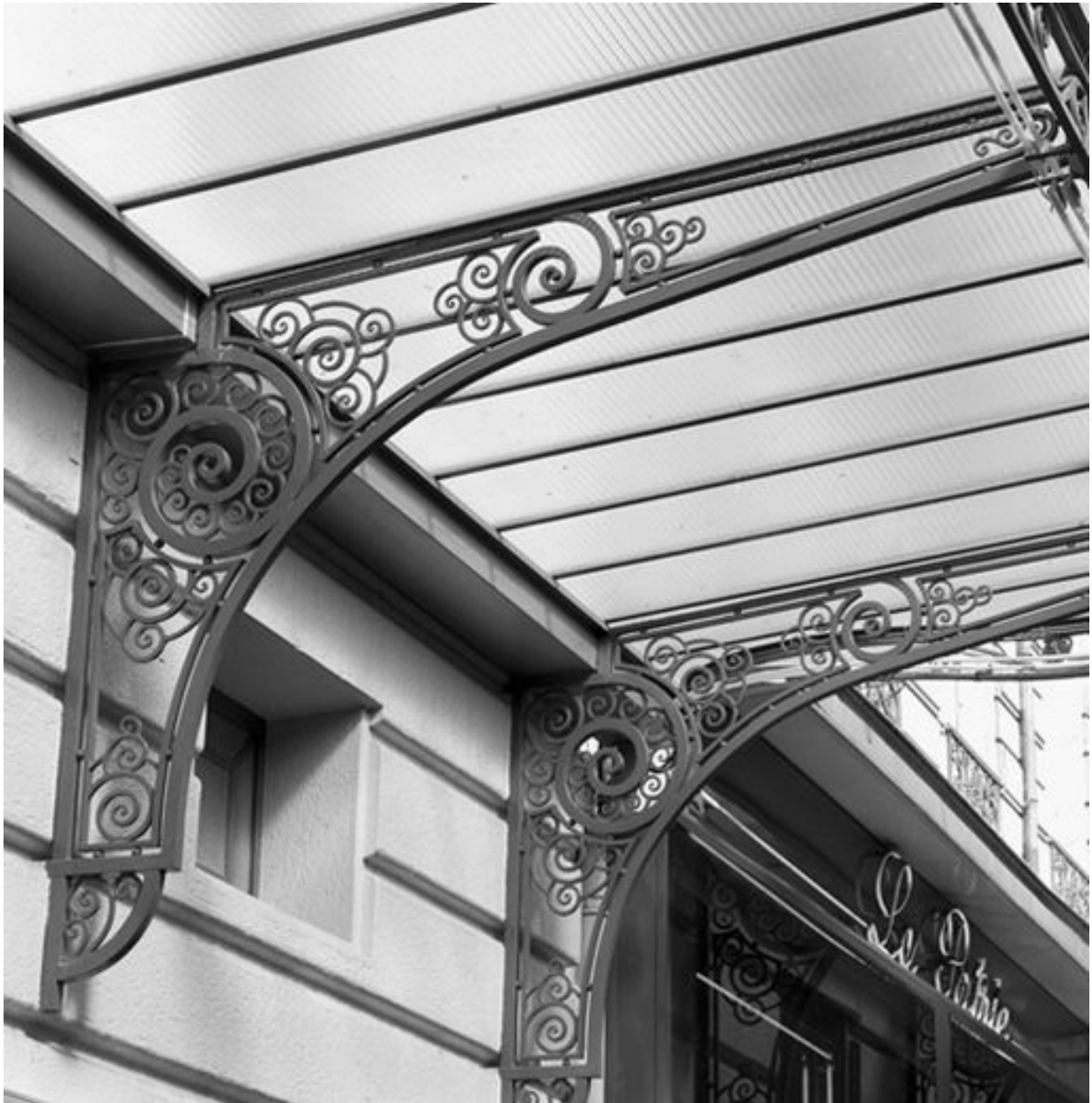
Détail de la marquise
