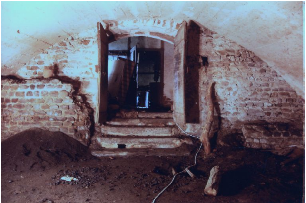
Vue partielle de la cave de la maison. Photographie monument historique, vers 1987.
