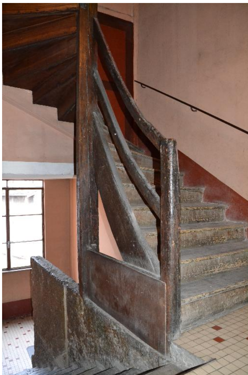
Escalier dernier niveau
