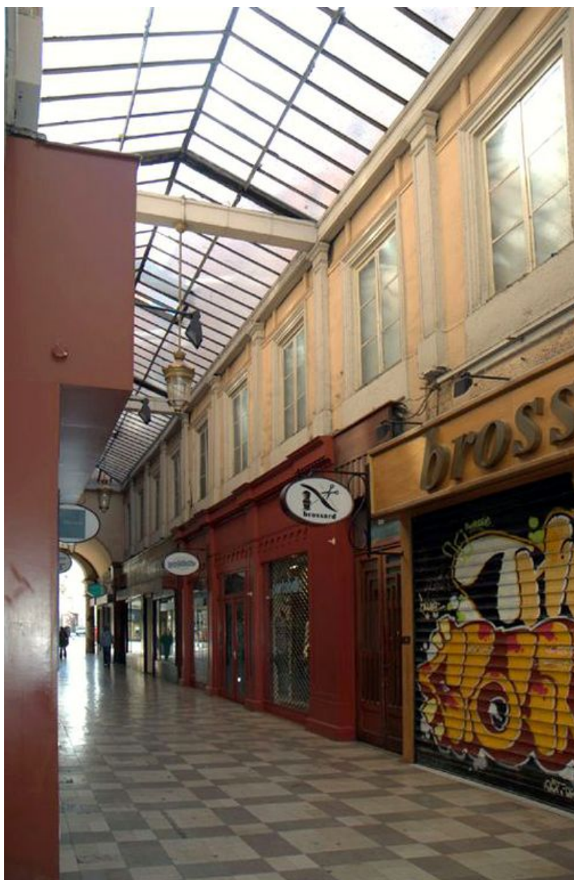
Vue du rez-de-chaussée
