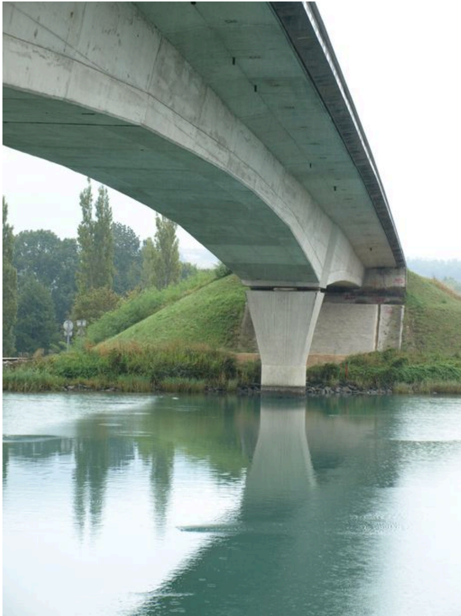
Arche centrale, vue partielle face aval (depuis la rive droite)
