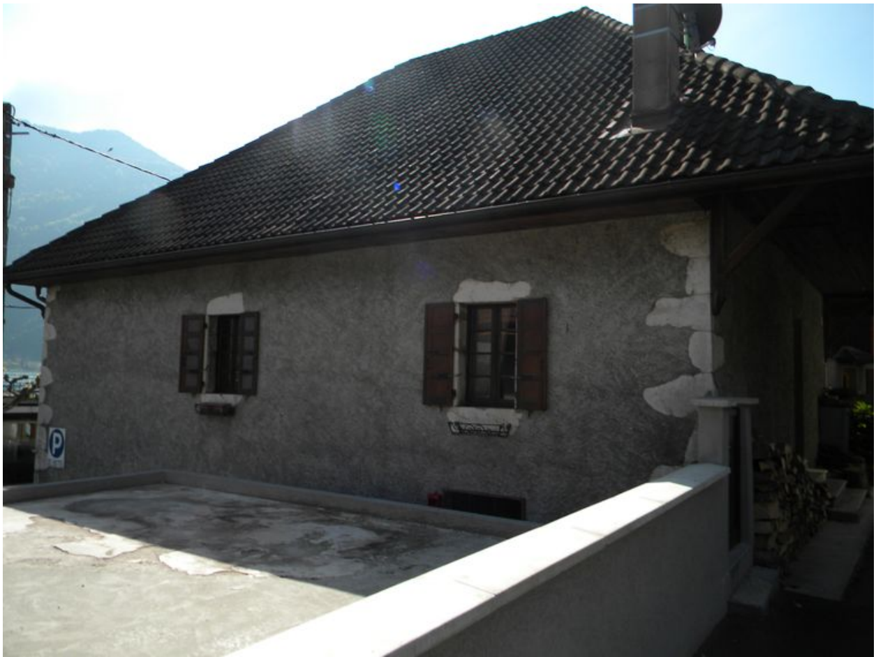
Façade nord d'une ancienne grange (2008 A3 360).
