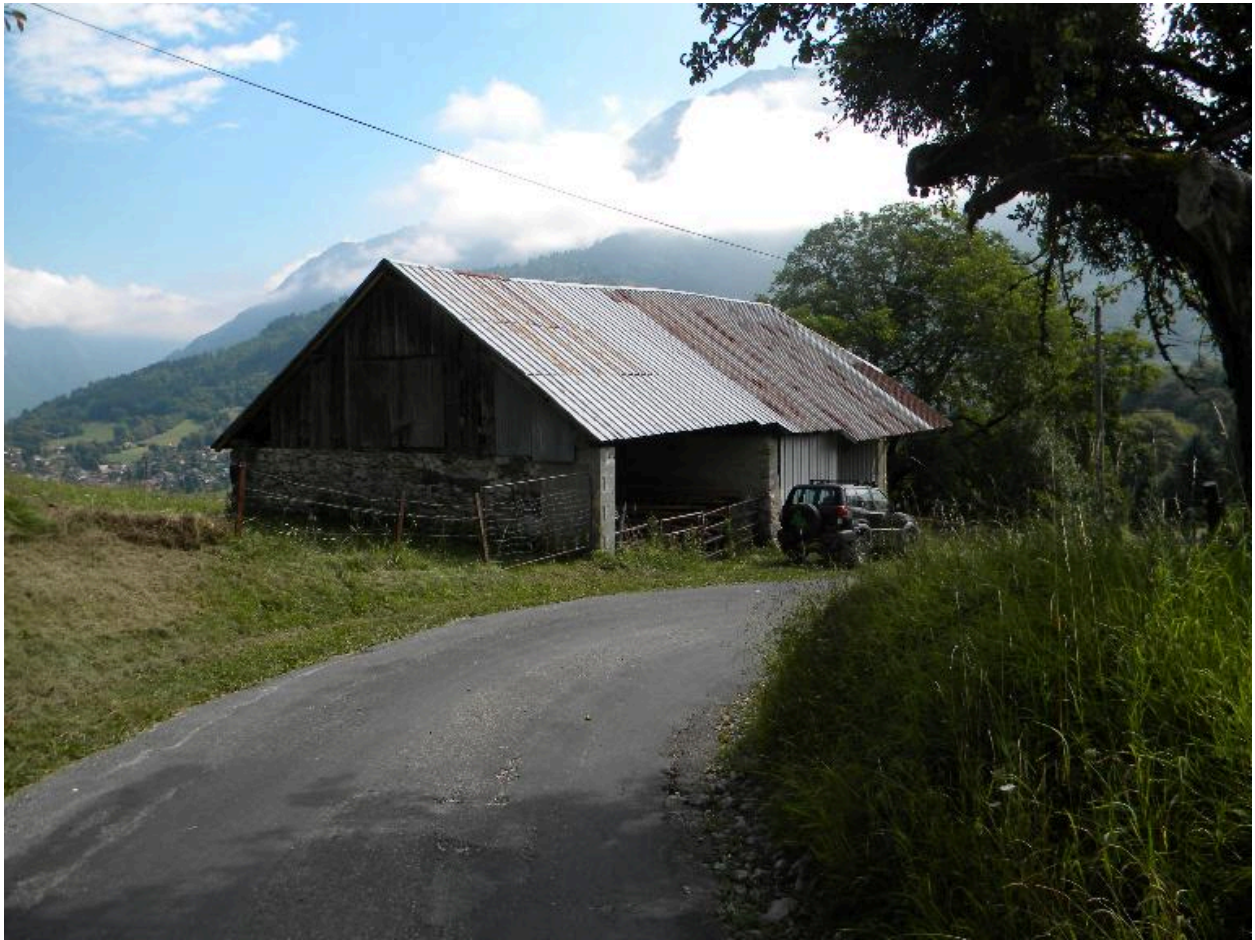
Vue du bâtiment agricole.
