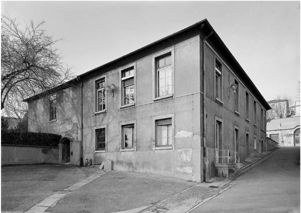
Bâtiment de la Lingerie (29, 30), vue générale sur l'angle sud-est
