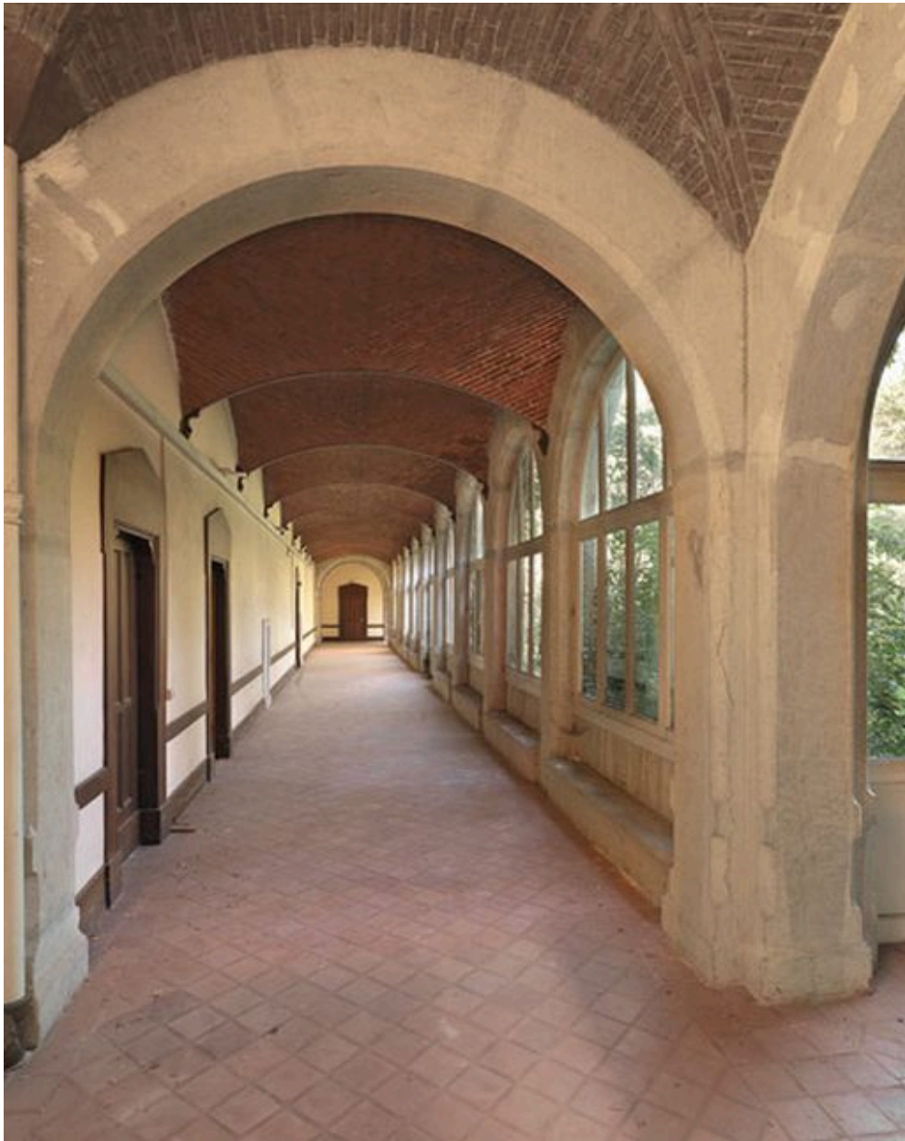
Galerie sud du cloître
