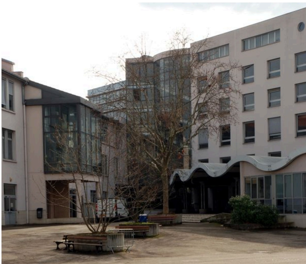
Bâtiments A et B : vue depuis le nord
