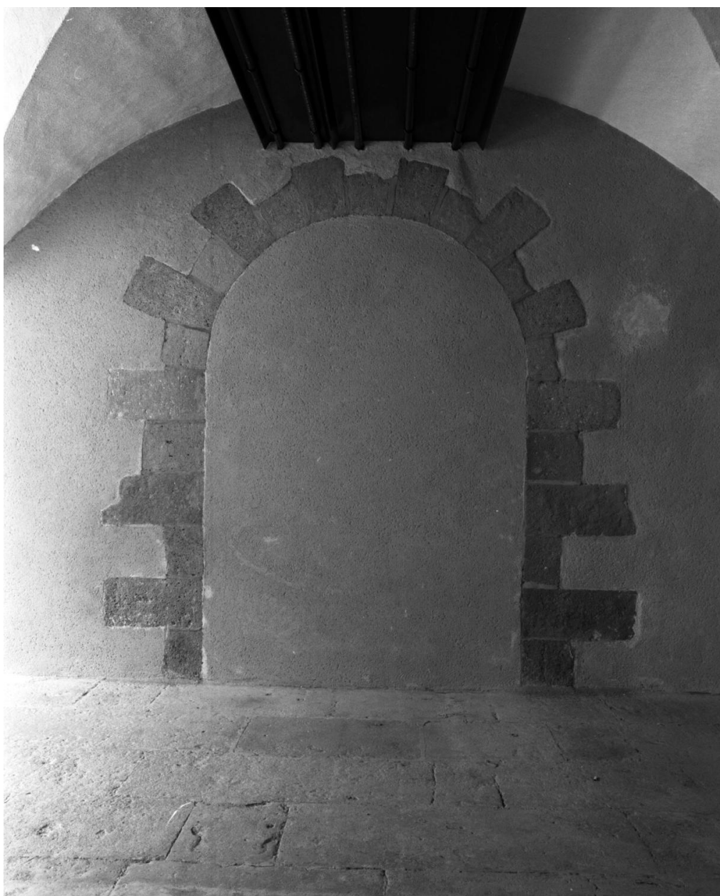
Bâtiment F (démoli). Détail d'une arcade murée, entre deux dortoirs.
