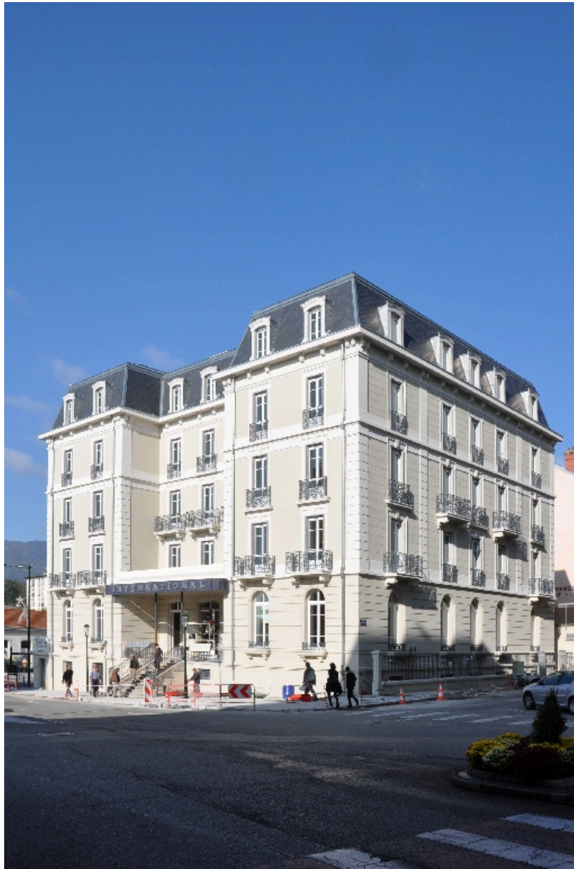
Vue générale après travaux
