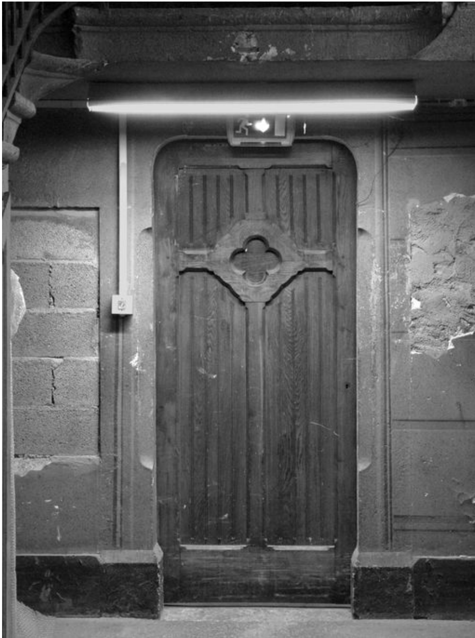
Cage de l'escalier ouest, porte d'accès à la galerie sud du cloître
