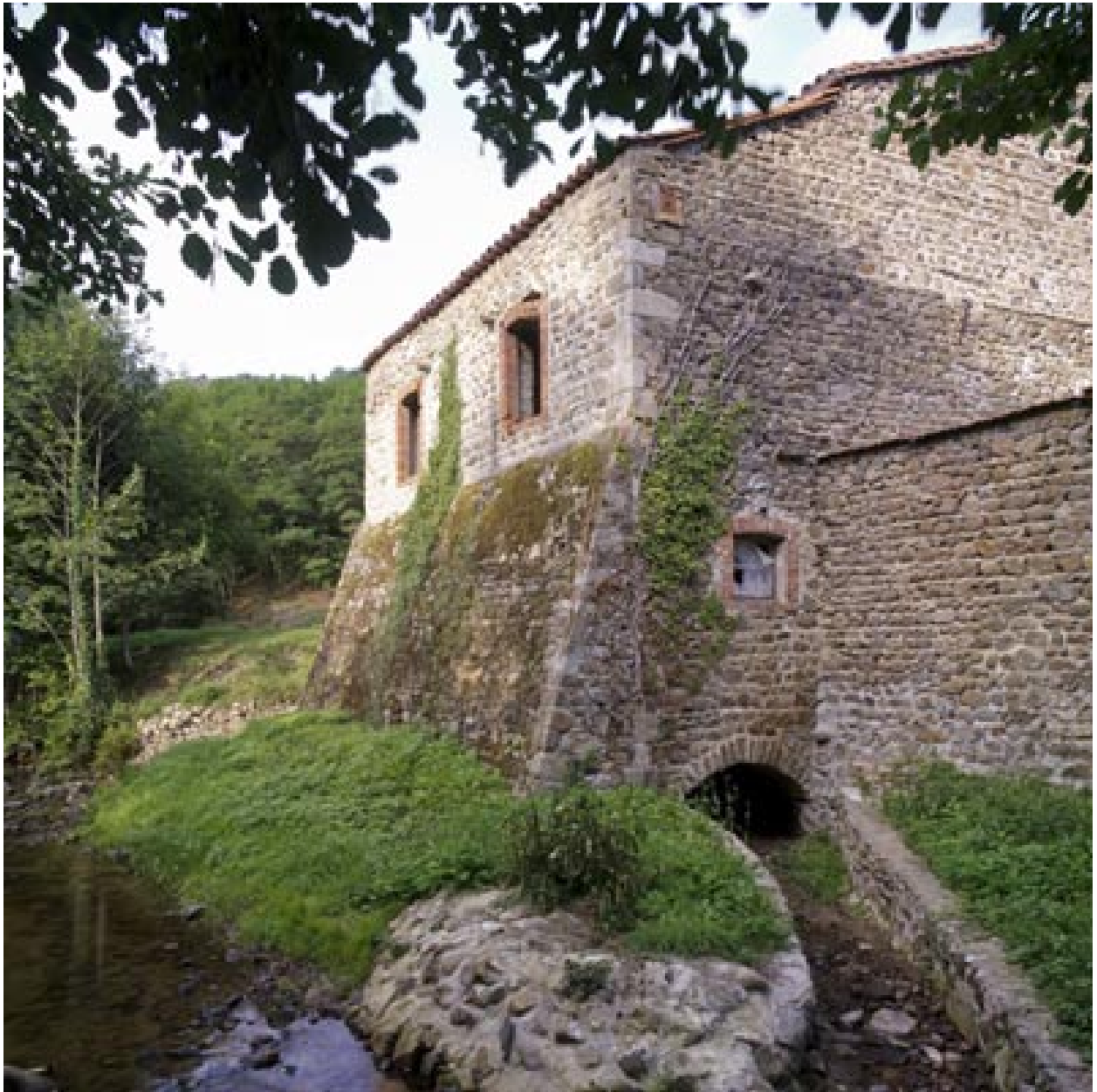
Vue de trois-quarts arrière, depuis l'ouest.
