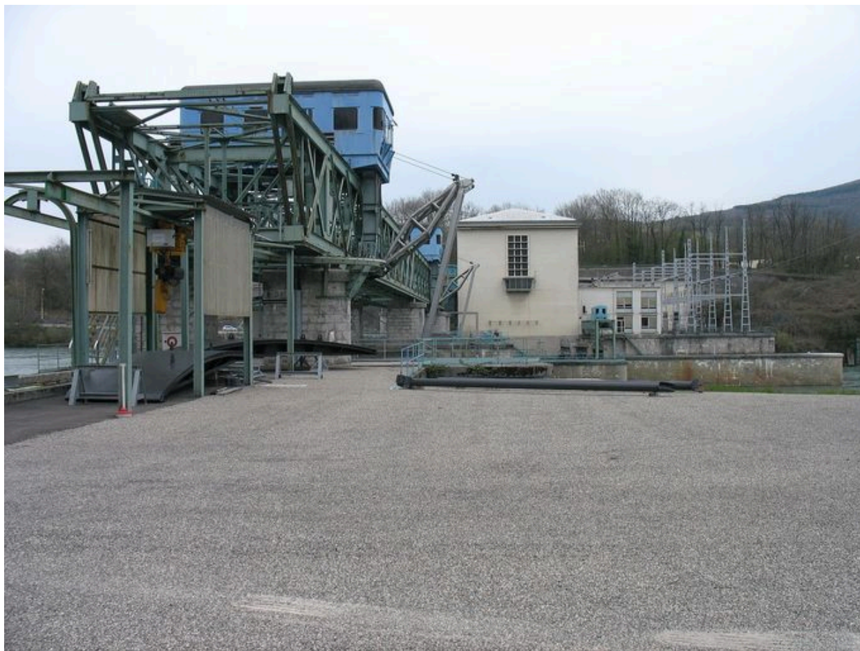
Vue de l'usine-barrage depuis l'ouest
