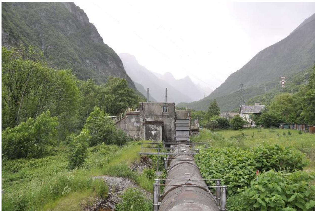
Vue des conduites forcées
