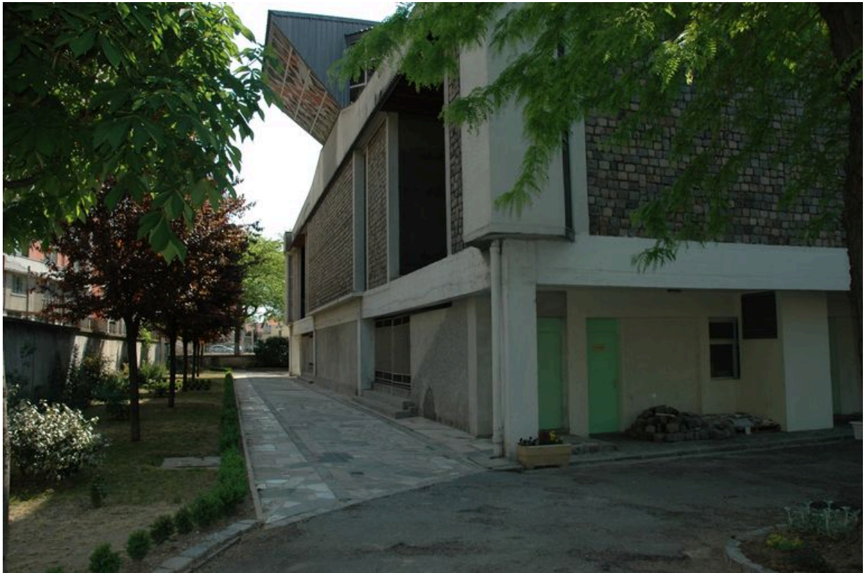
Vue d'ensemble du passage longeant la façade est de l'église depuis le nord
